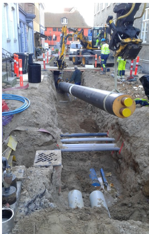
Eksempel på udgravning i en anden gade i Assens.
